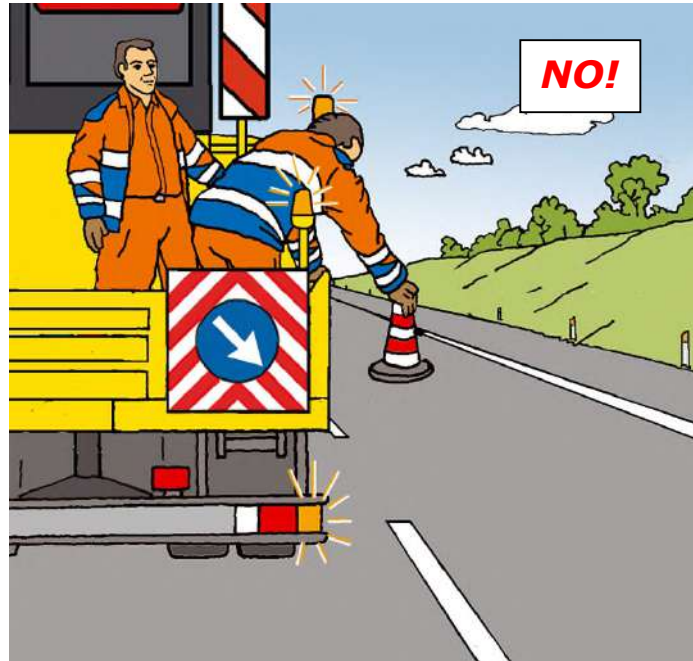
Figura 60 – Posizionamento dei coni o defleco: comportamento scorretto
