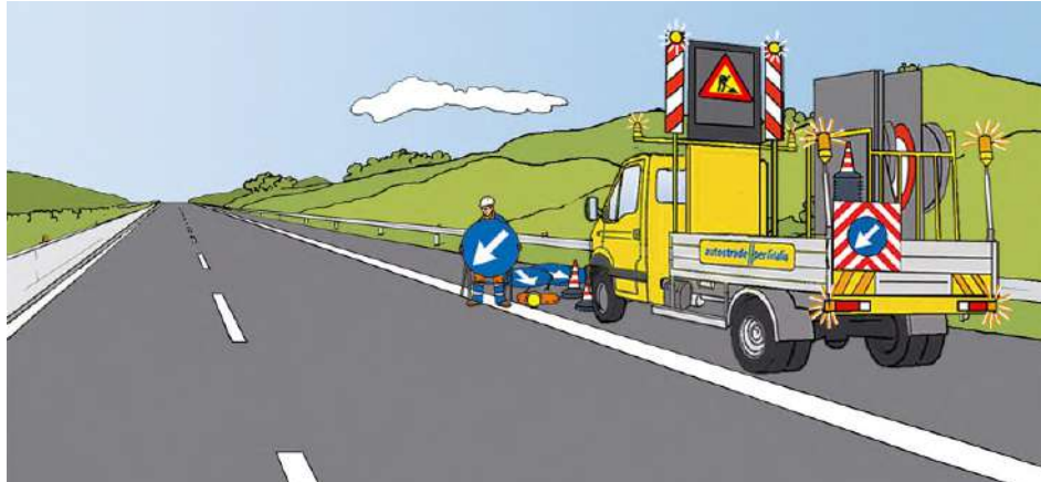
Figura 33 – Chiusura della corsia di marcia: scarico ed inizio installazione della segnaletica di esclusione della corsia
