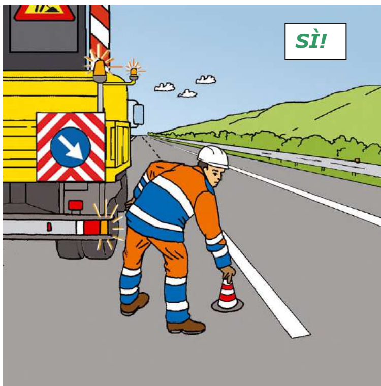
Figura 59 – Posizionamento dei coni o defleco: comportamento corretto
