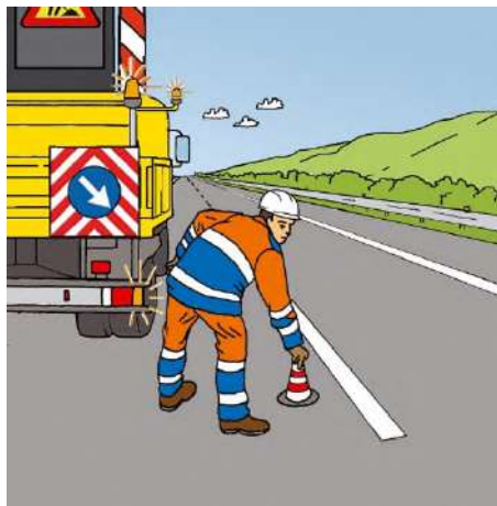
Figura 57 – Chiusura della corsia di sorpasso: inizio della posa dei coni
